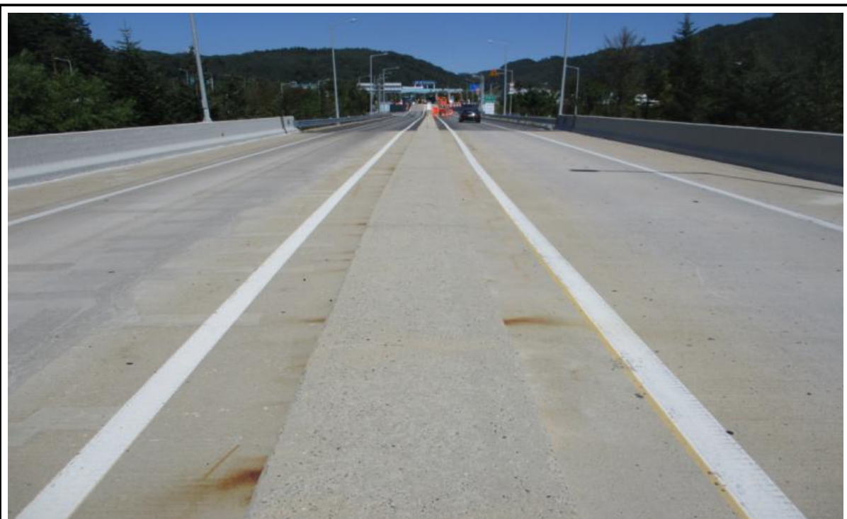
교량 상부 전경
